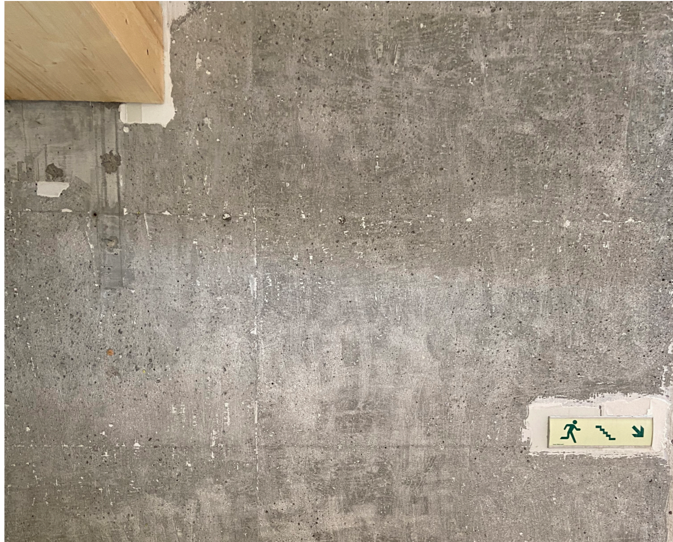
betongvegg - maling fjernet
