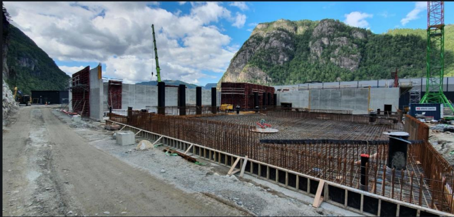
Hall 3 under bygging
