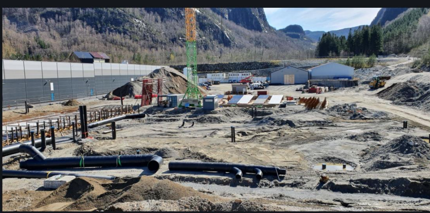
Hall 3 under bygging
